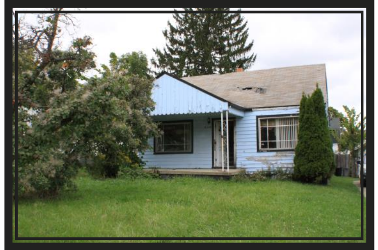
534 E. Boston: DEMOLITION
